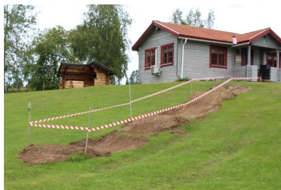
Nygrävda gupp vid skidleplatsen.
